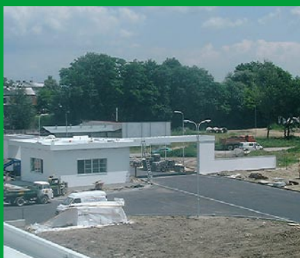
Stavba vrátnice OLO2
