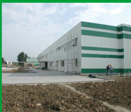
Stavba budovy OLO2
