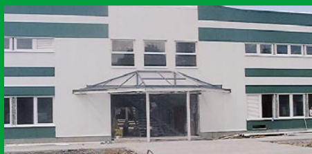
Nová budova OLO2
